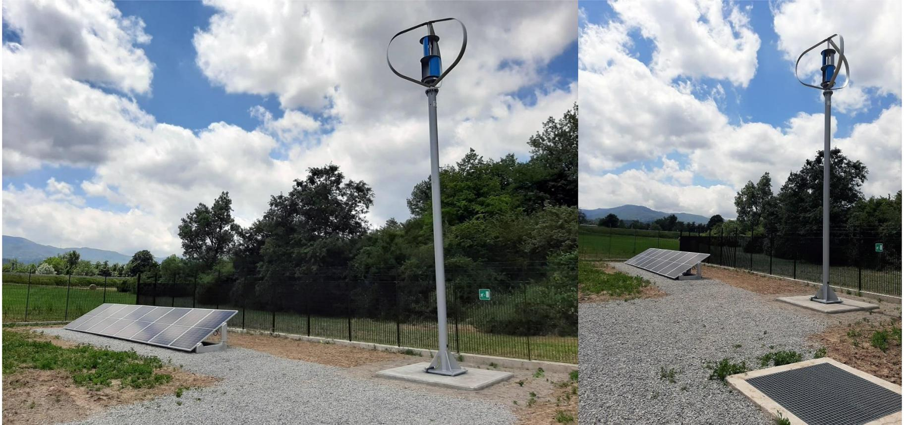
Il palo del generatore eolico ad asse verticale deve rispettare il disegno della flangia di connessione del generatore stesso, è possibile realizzare pali per installazione a terra oppure pali a disegno previa valutazione.
