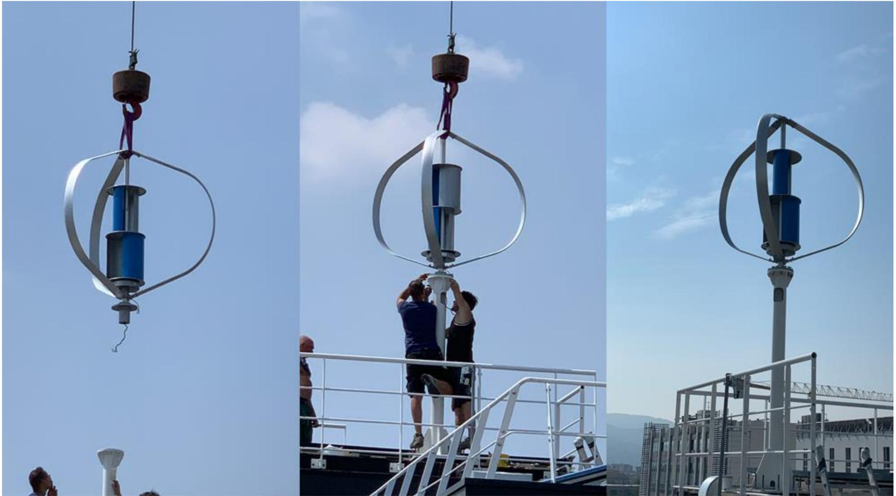
Il palo del generatore eolico ad asse verticale deve rispettare il disegno della flangia di connessione del generatore stesso, è possibile realizzare pali per tetto piano oppure pali a disegno previa valutazione. Indicativamente ed al massimo lo spazio utile su tetto per 1 turbina è di 2mq.
